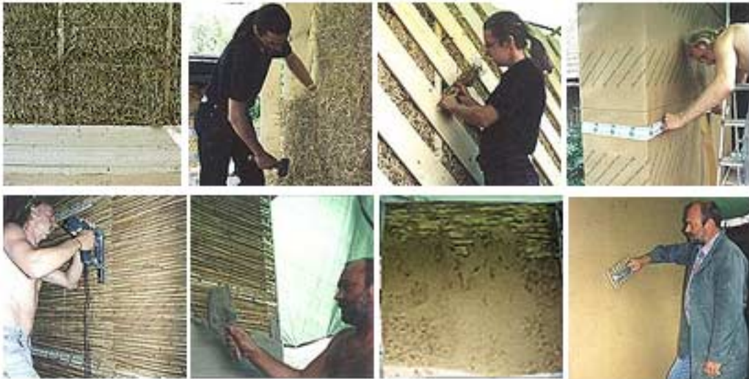
Abbildung 28: Errichtung der Probewand
