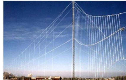
Bild 8. TCI vertikalt polariserat log-periodiskt antensystem vid Enköping Radio
