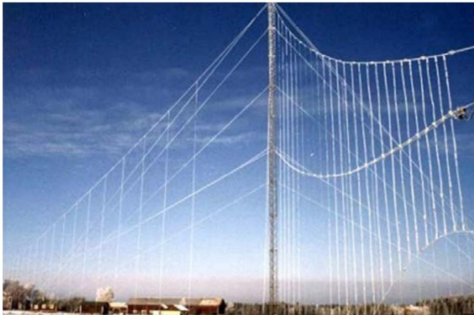
Bild 8. TCI vertikalpolariserat log-periodiskt antennsystem vid Enköping Radio
