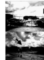
Fig. 7 El siniestro del Patio de Tanques de la Estación Mata R de PDVSA es un ejemplo de la interpretación falaz del riesgo de descargas eléctricas atmosféricas. Nótese las estructuras conductoras aterrizadas y no colapsadas, situadas por encima de los tanques. Estos son a su vez Jaulas de
