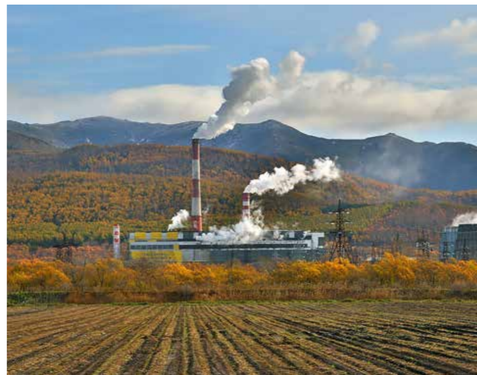
Южно-Сахалинская ТЭЦ Источник: холдинги.рф
