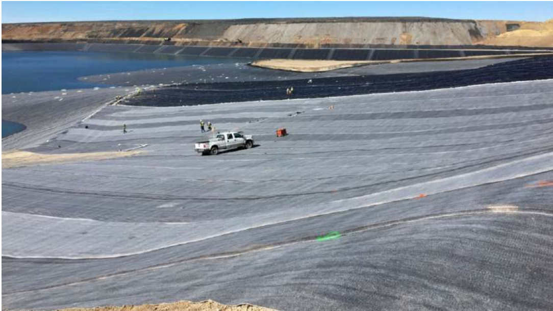
Рисунок 4. Пример строительства хвостохранилища с противодиффузионным экраном 7
