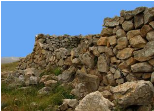
תמונה 30 הקיר בצפון מזרח שבו אין יסוד שתומך בקיר, ניזוק יותר משאר הקירות ברעידות אדמה
