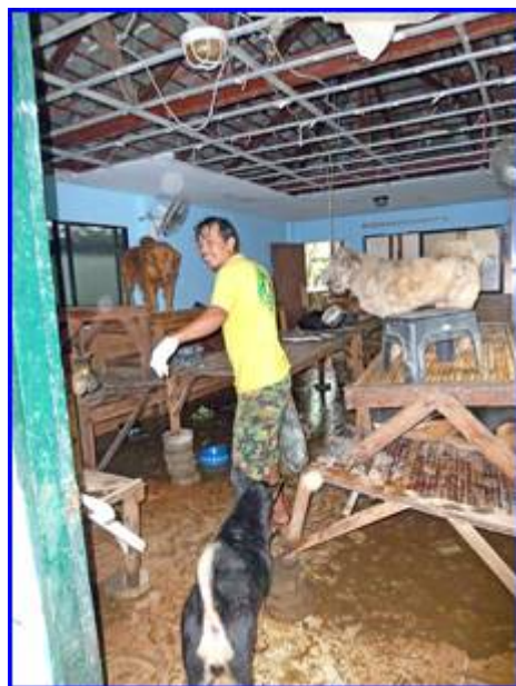
Zum Glück ist die Decke bei Stromausfall heruntergekommen! Ich hoffe, dass wir nicht schon bald wieder alles saubermachen müssen.
