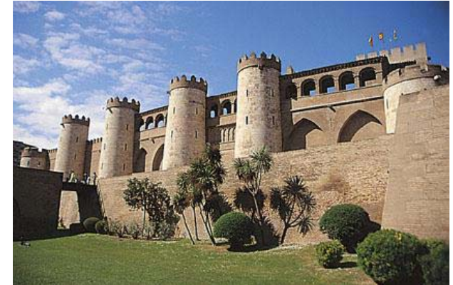
PALACIO DE LA ALJAFERIA. ZARAGOZA
