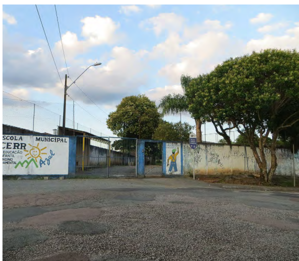
Escola Municipal Cerro Azul, no bairro do Tingui, em Curitiba, PR (DAR7 e Eloy Olindo Setti)
